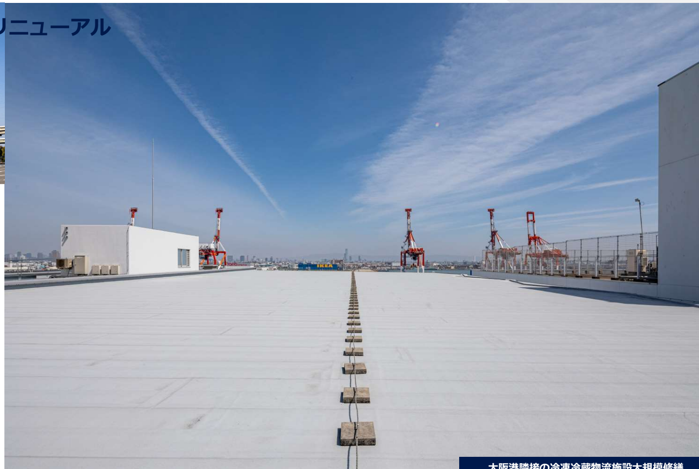
大阪港隣接の冷凍冷蔵物流施設大規模修繕
