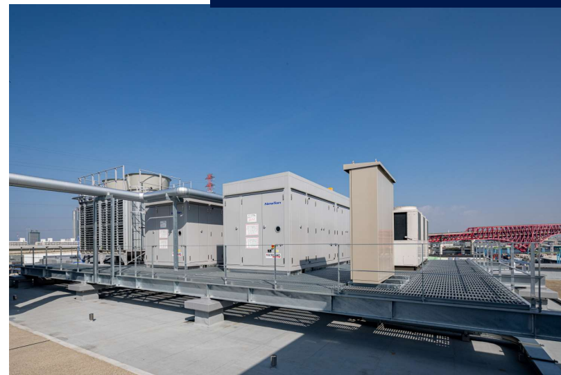
屋上 リニューアル
