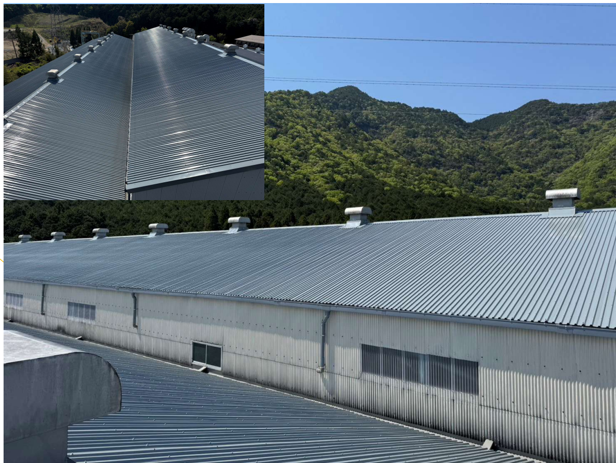
施工後 : スレート屋根にガルバニウム鋼板をカバー工法で施工
